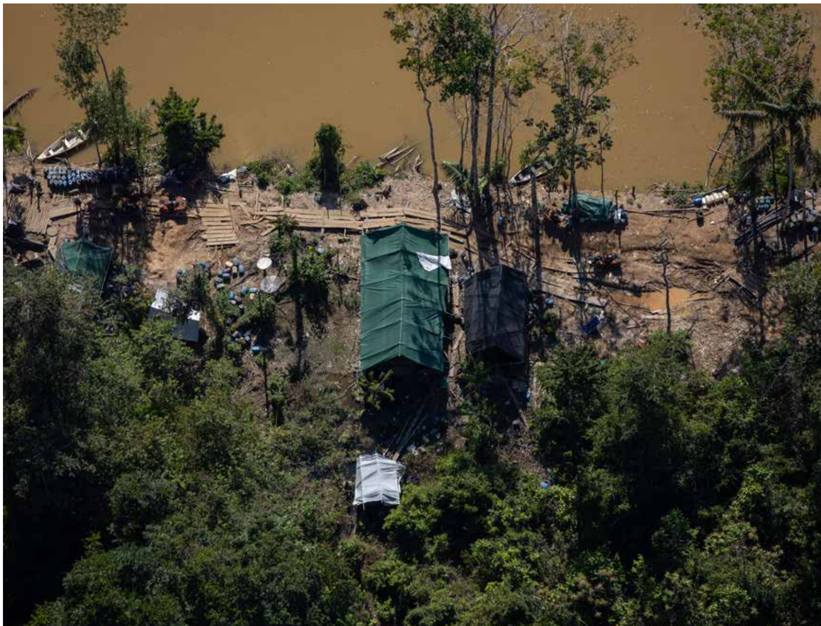
Foto 4: Quadriciclos no acampamento transportando combustível para os canteiros.
